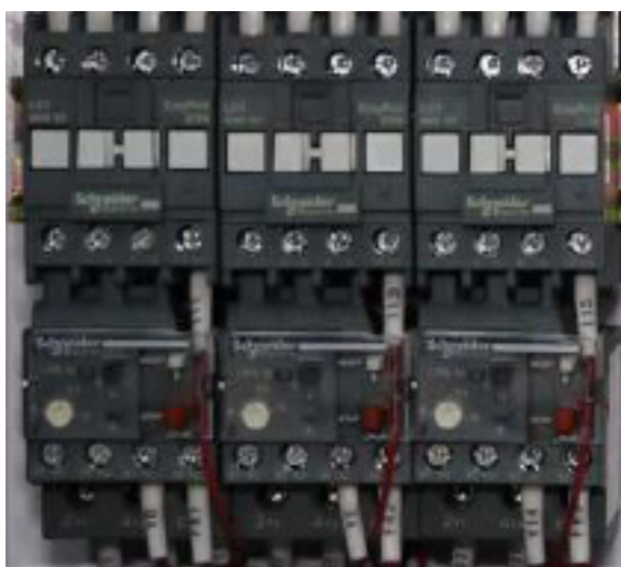
Termiske rele, AC kontaktorer fra Schneider
