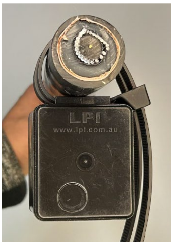
Figur 2: LSR-MAX monterert på HVSC Plus-leder.
